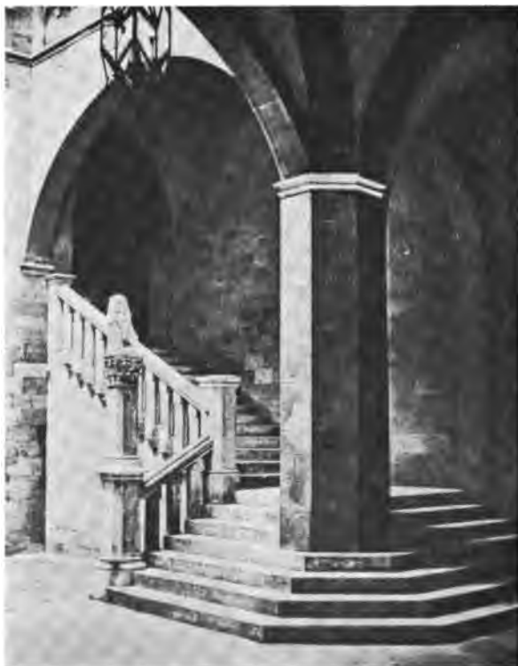
Fig. 97. — Escalier à double départ du Palais Pecci à Siègne. Rampe saillant sur le limon.
